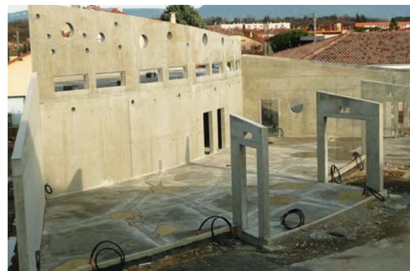
L'état actuel de la construction
